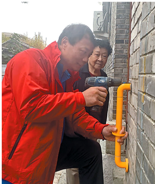
杨占岭(左)为居民维修无障碍扶手(施芳/摄)
