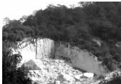
“福建南平生态破坏案”中遭到破坏的南平市延平区葫芦山部分山体。
