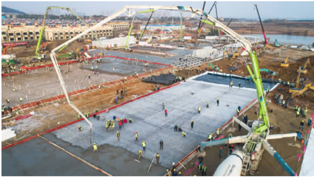
行业协会商会积极为防疫医院的建设和改造提供支持(图为1月28日拍摄的武汉火神山医院建设工地)
