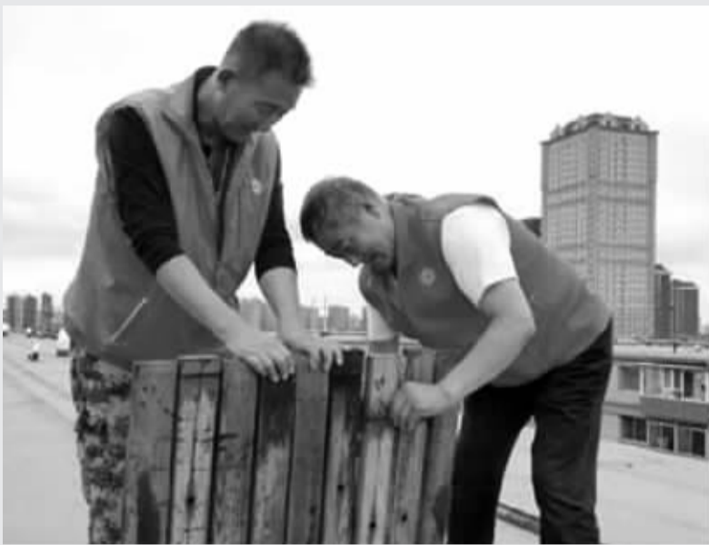
社区志愿者正在做顶楼防水处理
