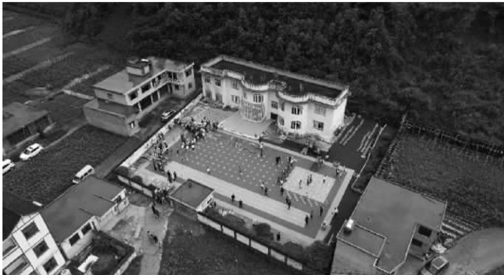
马家庄幼儿园铺设新场地后的全景
