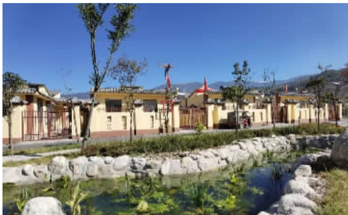
震后仅用51天就完成了建设任务的漾濞县苍山西镇金星新村安置点
