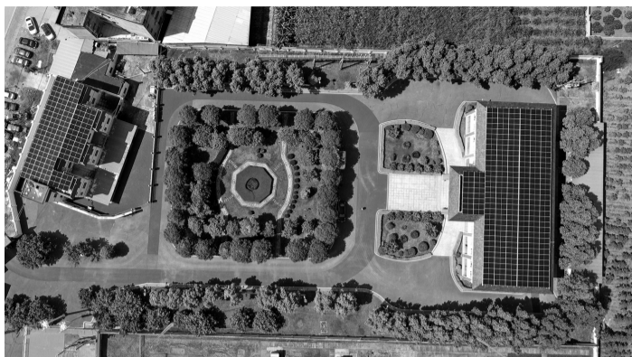
南方电网广西南宁横州六景供电所俯瞰图
